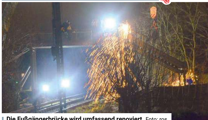
Die Fußgängerbrücke wird umfassend renoviert. Foto: ros
