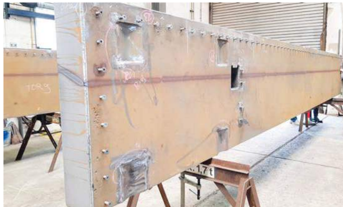
Nach dem Entfernen des bisherigen Korrosionsschutzes waren an den markierten Stellen der Flutschutztore in einem Zwischenschritt Torbereiche ergänzt und ausgebessert worden. Anschließend erhielten die Tore einen ganz neuen Korrosionsschutz. Foto: Firma Aug. Prien
