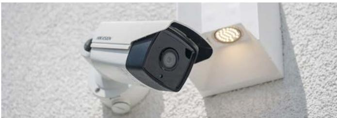
Die Halterungen von Leuchten und Kameras an der Hauswand können die Dämmung der Fassade beschädigen. Foto: Daniel Maurer/dpa-mag
