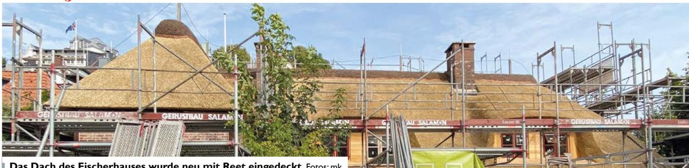
Das Dach des Fischerhauses wurde neu mit Reet eingedeckt. Fotos: mk
