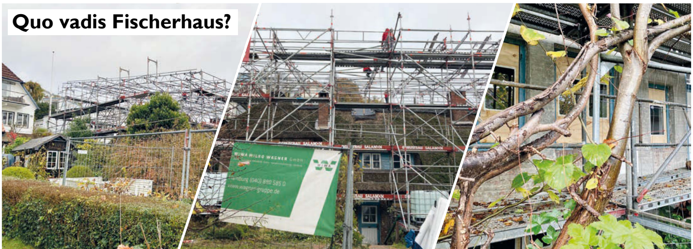
Die Bauarbeiten am Fischerhaus schreiten voran. Unter anderem wurde das alte Reet entfernt. Fotos: Ursula Plate
