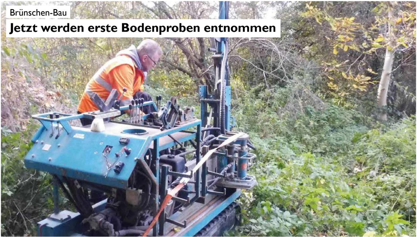
Derzeit ist ein Team von einem Gutachterbüro samt technischem Gerät an der geplanten Baustelle für das neue Oberstufenzentrum auf den Brünschenwiesen, um Bodenproben für ein baugelogeologisches Gutachten zu entnehmen. Foto: Jörn Steppke
