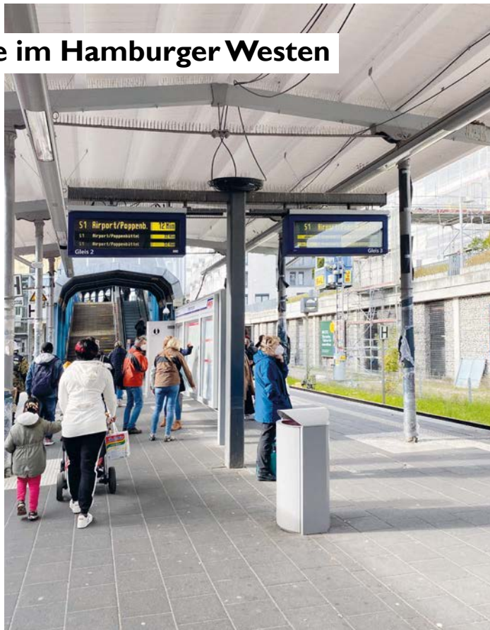
Immer noch ist der Blankeneser Bahnhof provisorisch hergerichtet. Die Fertigstellung verzögert sich ein weiteres Mal. Foto: mk
