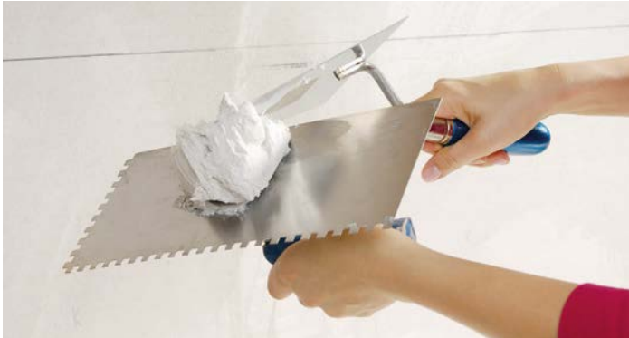
Der Fliesenkleber wird auf den Untergrund aufgebracht und anschließend mit dem Zahnpachtel verteilt. Fotos: dpa-mag
