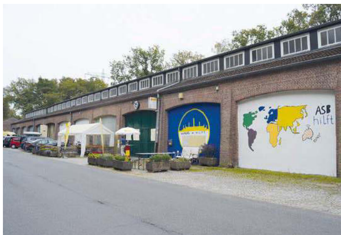
Das Gebäude ist eine denkmalgeschützte Panzerhalle aus dem Jahr 1939.
