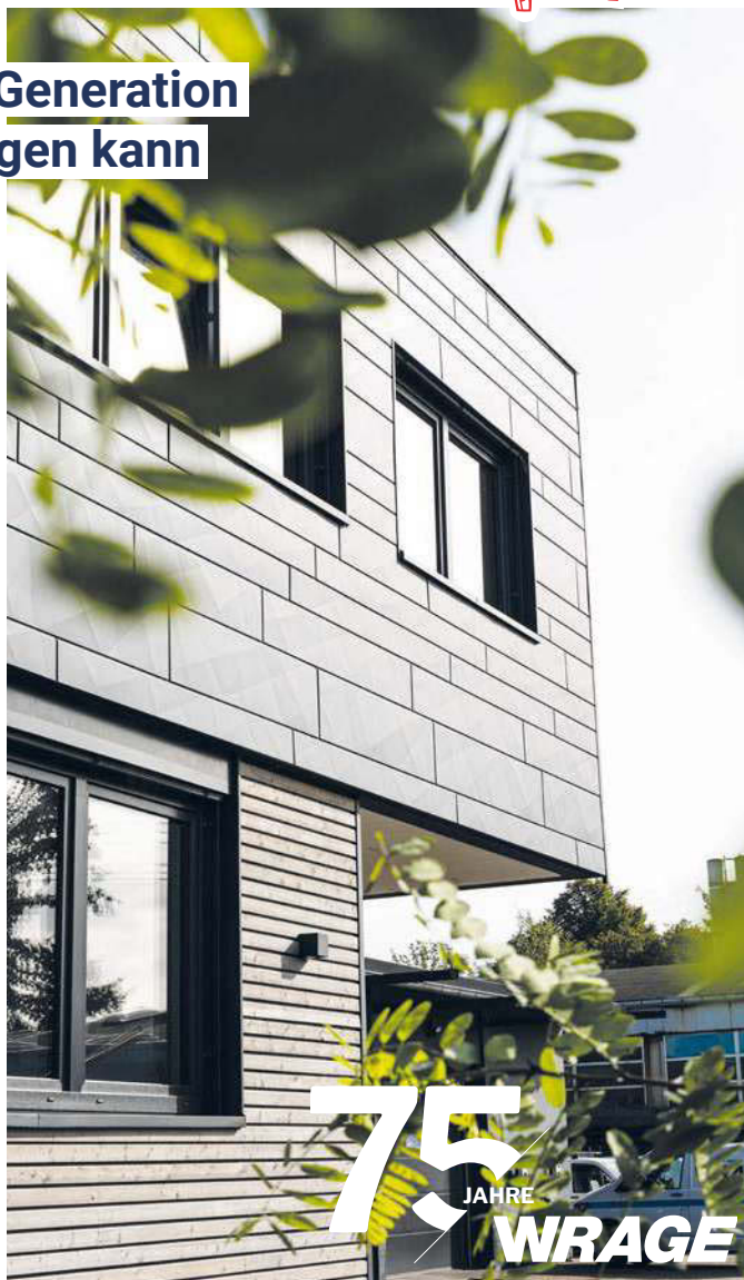
Das neue Kundencenter an der Industriestraße 55 in Wedel. Foto: Wrage
