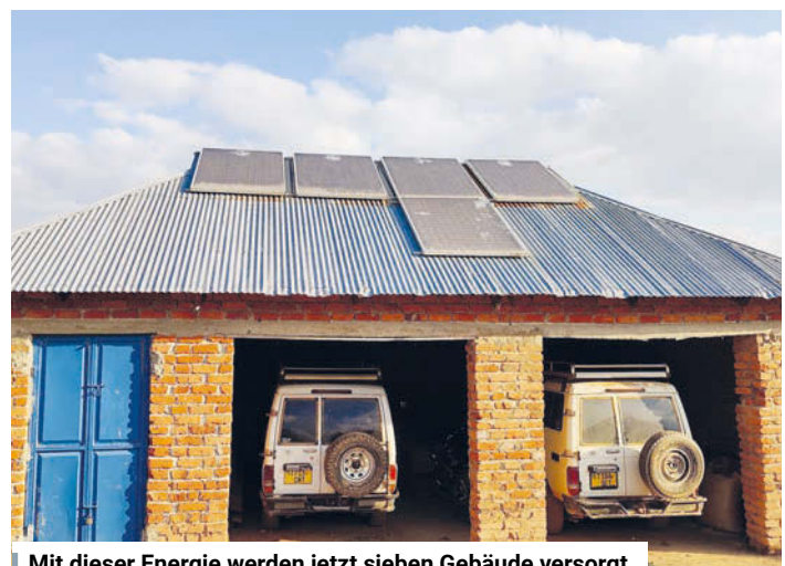
Mit dieser Energie werden jetzt sieben Gebäude versorgt.
